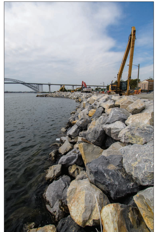
El nuevo dique que se está colocando en el Parque Dennis Collins de Bayonne forma parte de las actividades de saneamiento de PPG.
